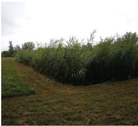
/ Pommevic – station à filtres plantés
