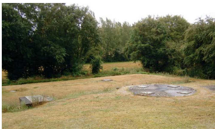
/ Station à filtres à sables à Bardigues
