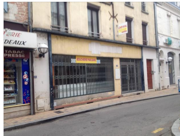
Locaux commerciaux vides, Rue de la République, Valence d'Agén
