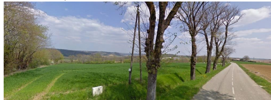
Vue sur le site depuis la RD28
