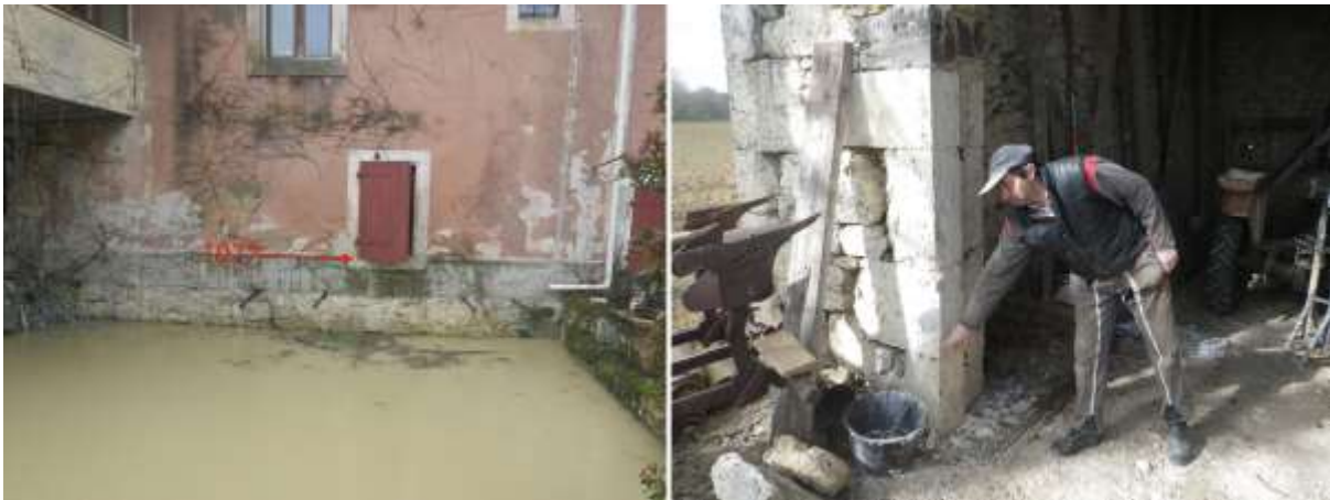
Exemples de repères de crue datant de juillet 1977 obtenus par témoignage (Source AGERIN).
