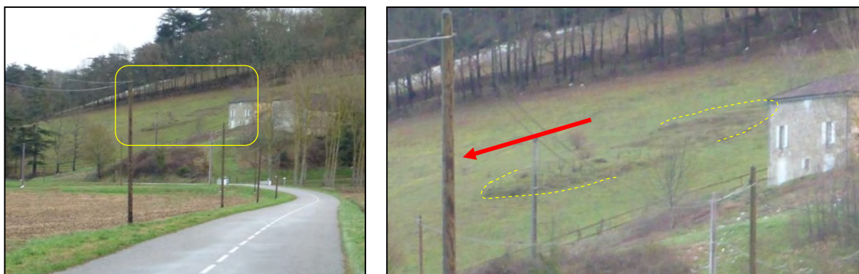
Figure 22 : Glissement superficiel dans le versant au Nord du Château d'Andas [Source : IMS RN ]
